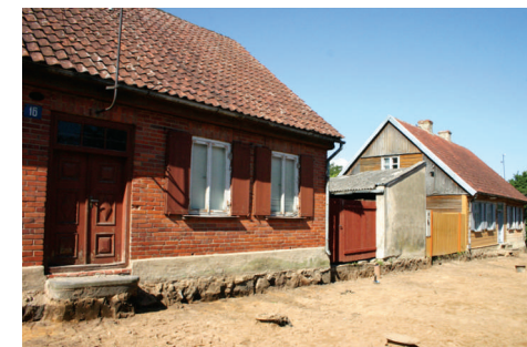
Rekonstrējot ielu ir atsegti seklie vēsturisko ēku pamati. Šādi rīkojoties var rasties sienu deformācijas.
