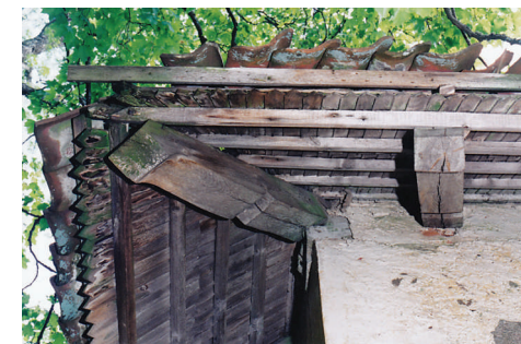
Zem dakstiņiem zemsegums no gropētiem priedes koka šindeļiem.
