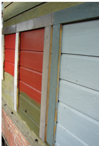
Krāsojuma tona piemeklēšana un paraugu laukumu uzklāšana.
