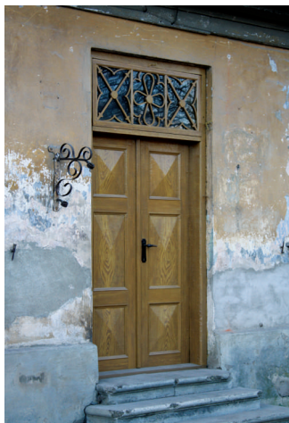
Atjaunotas durvis āderējuma tehnikā, imitējot ozolkoka šķiedru.
