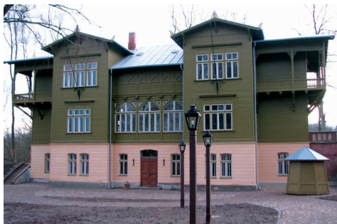
Kuldīgas muzeja ēka Pils ielā 5, kas krāsota saskaņā ar krāsu zondāžu, jo pārvestās koka ēkas piesaisti zemesgabalam projektējis arhitekts P. M. Berči ar ideju, ka piesaistes - cokola stāvam jāatšķiras no atvestās koka ēkas, kas krāsota toni, lai tā iekļautos kopējā parka ainavā.
