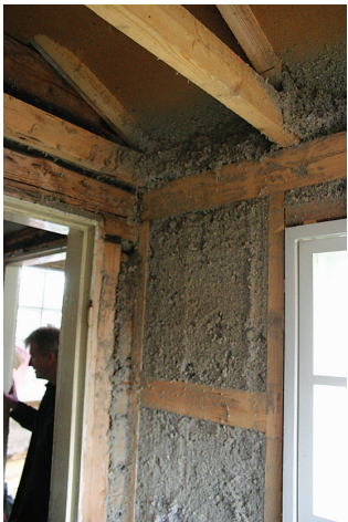
Sienu siltināšana ar ekovati no telpas puses.
