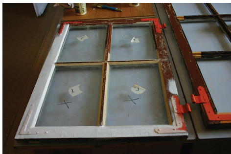
Veicot vienkāršotu logu remontu netiek izstikloti stikli un noņemts aprīkojums, bet saglabāts labā stāvoklī esošais ķītejums, aprīkojums tiek notīrīts, gruntēts un vēlāk tas viss gruntēts ar lineļļu un divas reizes nokrāsots. Tiek ietaupīti līdzekļi, laiks un saglabāts viss vēsturiskais.
