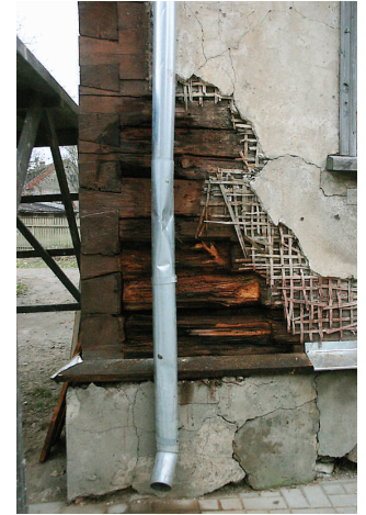
Ar kaļķa javu apmestas koka ēkas stūris. Ilgstoši neremontējot notekas, tiek bojāta konstrukcija un apmetums. Koksne tiek apstrādāta ar antiseptizējošu līdzekli, tad tiks likti skalīni un apmetums. Kuldīga.
