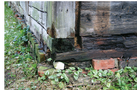
Pārāk daudz uzaudzis grunts līmenis. Koka ēkas apakšdaļas konstrukcijas tiek bojātas. Kuldīga.
