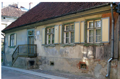
Atjaunotie būvgaldniecības elementi ēkā Kalna ielā 15, notīrot visus iepriekšējos krāsu slāņus.
