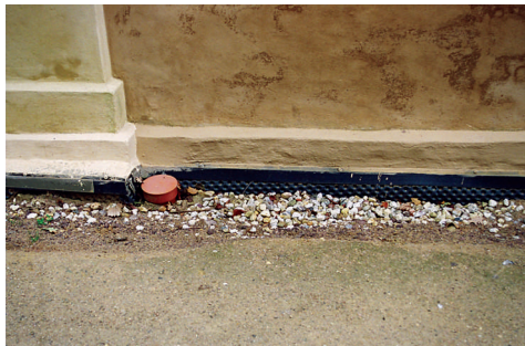
Pamatiem veikta ārējās plaknes nosegšana ar ruļļu tipa hidroizolācijas materiālu, kuram ir gaisa šķirkārta.
