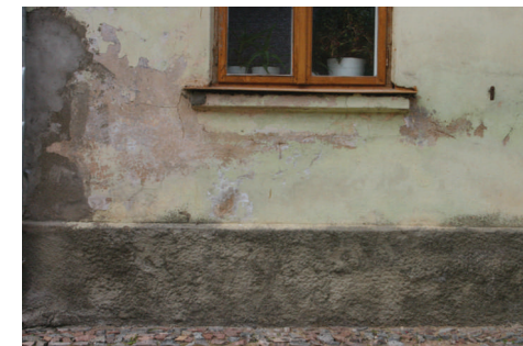
Cokols apmests ar cementa javu, kas uztur un neļauj iztvaikot mitrumam. Līdz ar to mitrums no pamatiem uzkāpis un sāk izdalīties pleķu veidā fasādes pirmā stāva līmenī. Kuldīga.
