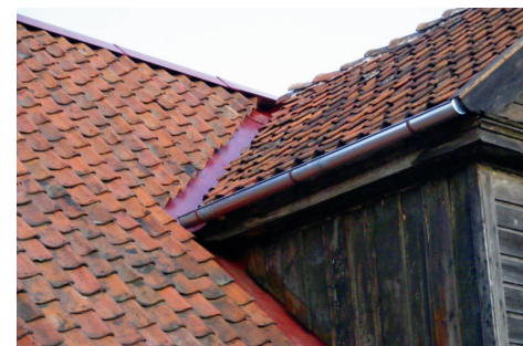
Lokāls jumta seguma remonta darba procesa un pabeigta. Izdarīts viss nepieciešamais. Saglabāts Kurzemē raksturīgais zemsegums – dēļi ar pārliedumu, faktūras un patina.
