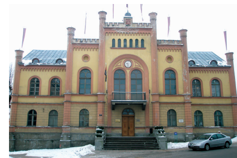
Ēka Baznīcas ielā 1, pirms sākotnējā krāsu toņa atjaunošanas.
