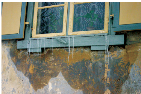
Nepareiza vēsturisko logu ekspluatācija. Ja telpas pusē nav otra vērtņu (t.s. ziemas) kārtā uz stikla veidojās liels kondensāts. Šādi lietojot logus tiks sabojāta fasāžu apdare un ārējo konstrukcija. Pēc būtības tā ir kaitnieciska rīcība.
