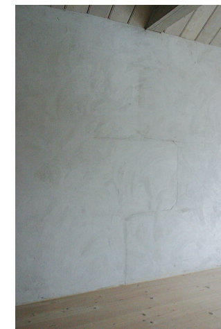
Siena no iekšpuses siltināta ar fibrolīta plāksnēm. Plāksnes nav pietiekoši izžāvētas un līdz ar to radušās plaisas.
