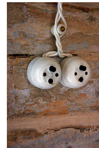
Koka siena krāsota ar kaļķu un krīta krāsu vairākos slāņos, kas atstāti, jo veido telpas vēsturi. Uz koka sienas elektroinstalāciju vislabāk uzlikt – vītne vadi uz izolatoriem, sens porcelāna slēdzis. Kuldīga.
