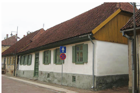
Atjaunotie būvgaldniecības elementi ēkā Kalna ielā 13, notīrot nepieciešamo un pārkrāsojot toni atbilstoši krāsojuma zondāžam.
