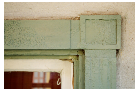
Loga naseglīstes fragments - stūris Kuldīgā, Kalna ielā 15 pirms darbu uzsākšanas, pēc nenoturīgās krāsas notīrīšanas un nokrāsošanas.
