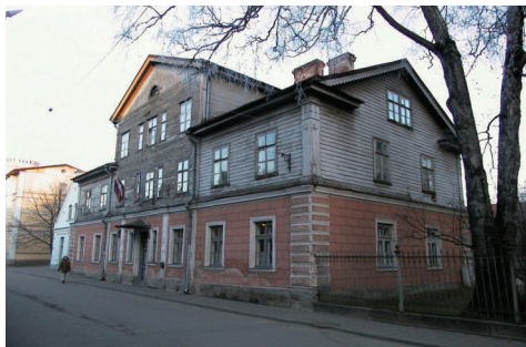
Esošais krāsojums ēkai Liepājas ielā 33.
